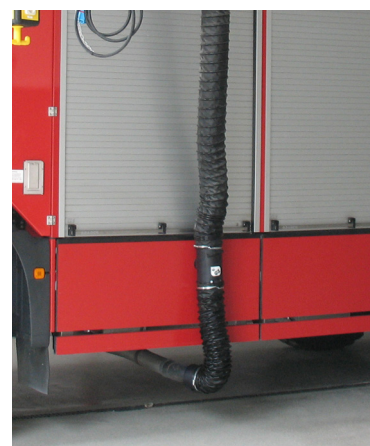
Magnetgekoppelter Abgas-trichter in aufgehängtem Schlauch.
