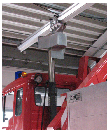
Seitenverschiebbare Absaughaube für oberliegendem Auspuff.
