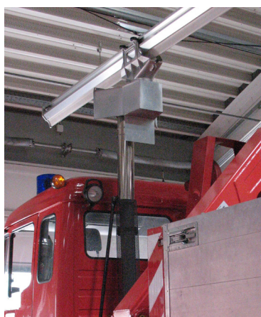
Hotte d'aspiration réglable latéralement pour la sortie supérieure.
