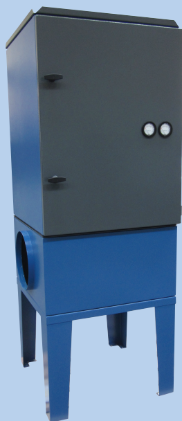
Foto: AFK 1M7 på ben og med Minihelic-differens-tryks- manometer
